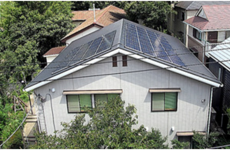
都内の市民発電の一つ「世田谷みんなのエネルギー」は、教会の屋根に太陽光パネルを置いている =東京都世田谷区
