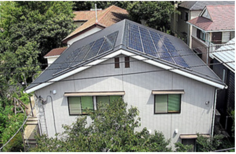
都内の市民発電の一つ「世田谷みんなのエネルギー」は、教会の屋根に太陽光パネルを置いている =東京都世田谷区
